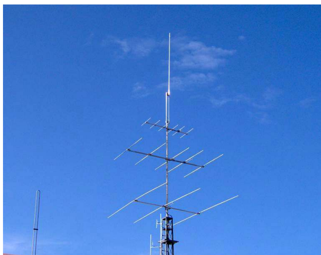
Nou vertikaal met 7 antenas in sig. Van bo naonder: 6m J-pole, 2m,6m en 10m yagi's, vertikaal 70cm,6m en 2m. Links is ook 'n 2m Slim-Jim te sien.
